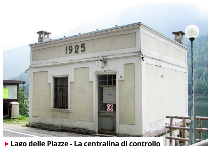
► Lago delle Piazze - La centralina di controllo
