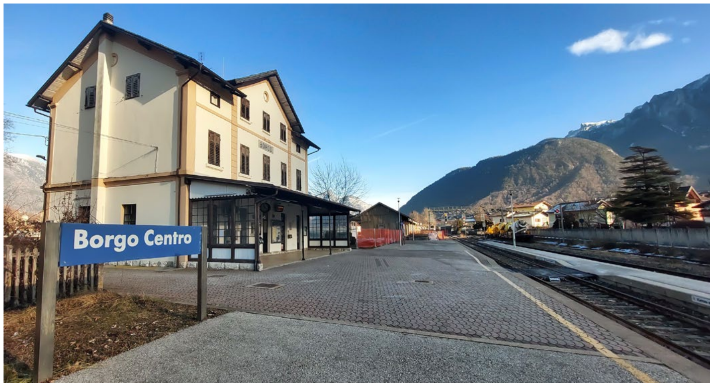
► La stazione ferroviaria di Borgo Valsugana
